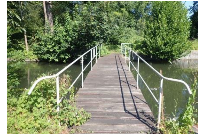
2 Steg am Wasserkraftwerk
