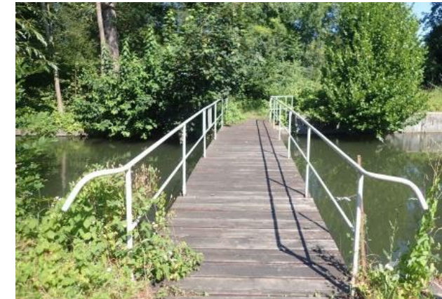
2 Steg am Wasserkraftwerk
