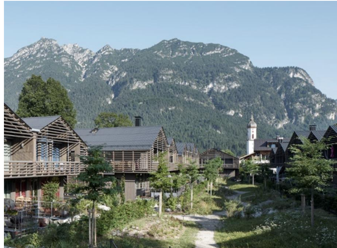
Garmisch, Baugemeinschaft Quartier, Architektur Bembé Dellinger Architekten - Foto: Bauzeit Netzwerk
